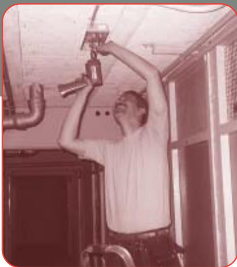
Dolf Kuiper van Service & Onderhoud plaatst nieuwe TL-verlichting
